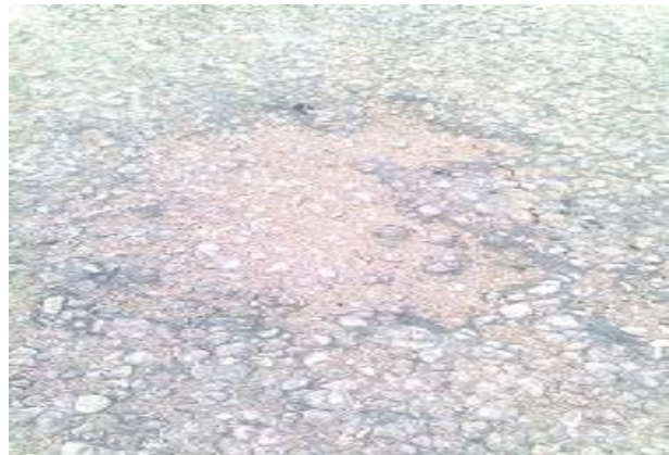
الصورة رقم(12): تآكل السطح وتأثير الجو متوسط الشدة
