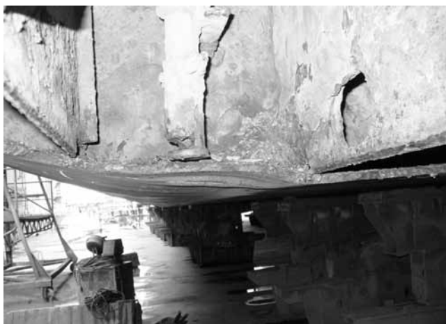
Rys. 4. Wymiana poszycia dennego. Naprawa usztywnień rampy rufowej Fig. 4. Replacing the hull bottom. Repair of stiffening stern ramp
