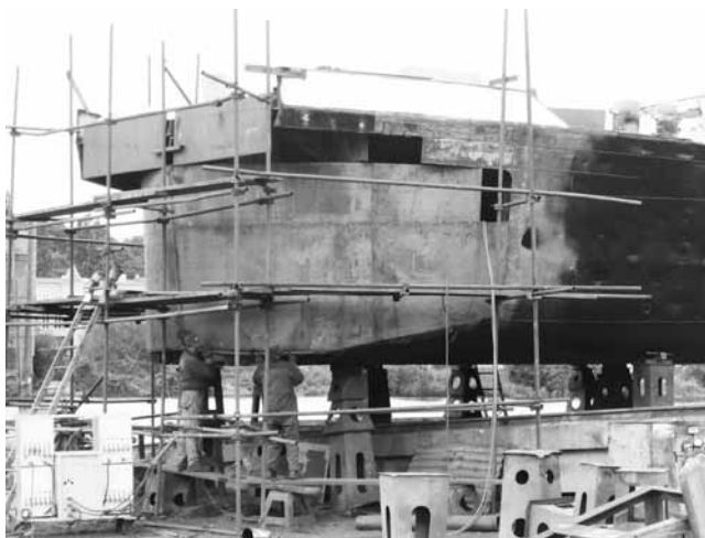
Rys. 3. Odbudowa (przebudowa) dziobu barki Fig. 3. Reconstruction of barge bow
