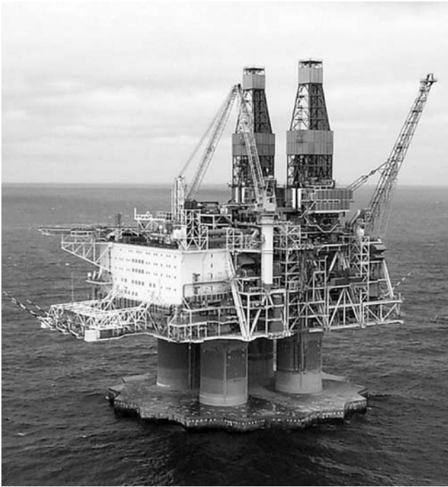
Rys. 5. Platforma Hibernia. Stoi niedaleko od brzegów Nowej Funlandii i jest najcięższą platformą na świecie. Jej całkowita masa wynosi 1,2 mln ton, na co składają się: 37 tys. ton części nadwodnej (topside) umieszczonej na podstawie o masie 600 tys. ton, i stały balast o masie 450 tys. ton, który był dodany, aby zabezpieczyć platformę przed przesunięciem. Wewnątrz podstawy znajdują się zbiorniki zdolne przechować 1,3 mln baryłek ropy naftowej. Konstrukcja jest tak zaprojektowana, aby nie dopuścić do uszkodzenia platformy przez góry lodowe [15]
