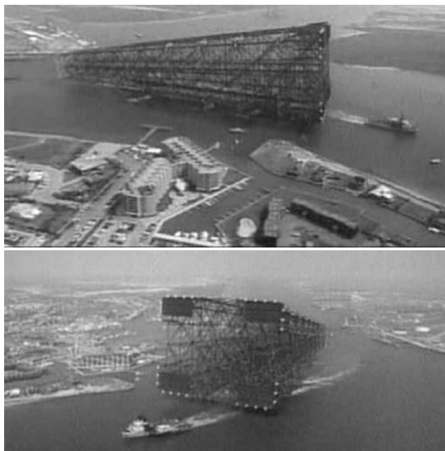
Rys. 2. Transport na barce największej na świecie wieży wykonanej w całości dla platformy Bullwinkle [2]
