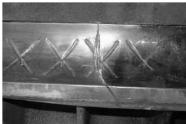
Rys. 14. Uszkodzony – pęknięty korpus wraz z powłoką z brązu
