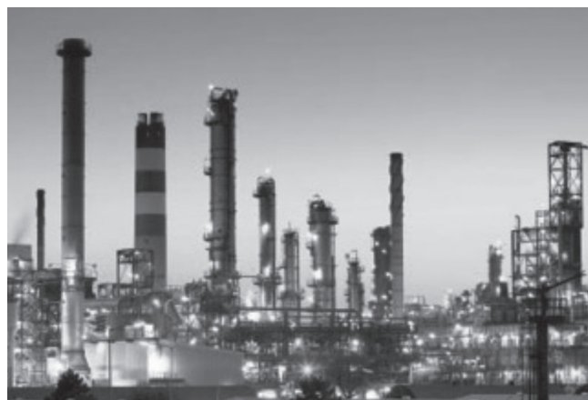
Rys. 1. Zdjęcie instalacji przemysłowej [3] Fig. 1. View of chemical plant
